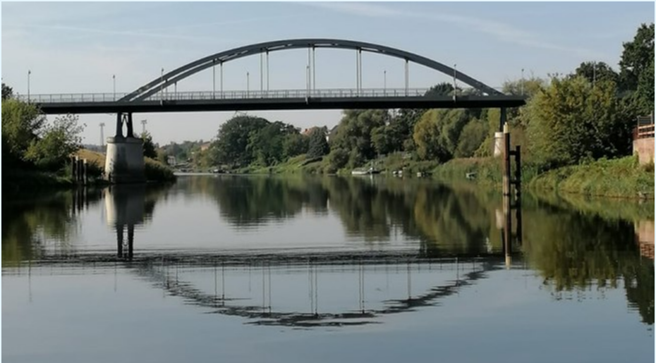
Eisenbahnbrücke in Eisenhüttenstadt
